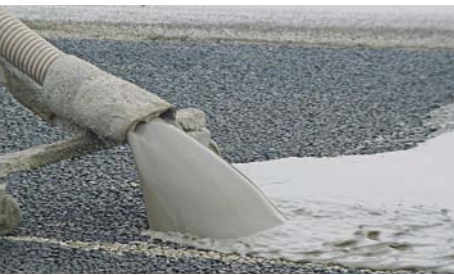
Particolare iniezione della boiaccia
