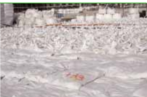
▼ Stesura di sacchi e sacconi di Igroperlite® in multistrato per stratigrafie di spessore elevato
