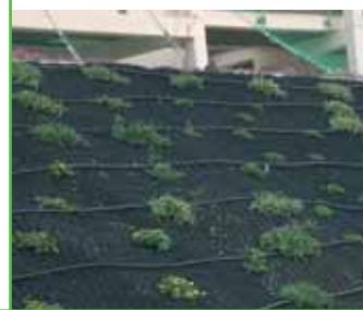
▼ Tubi irrigatori a goccia e vegetazione di primo impianto
