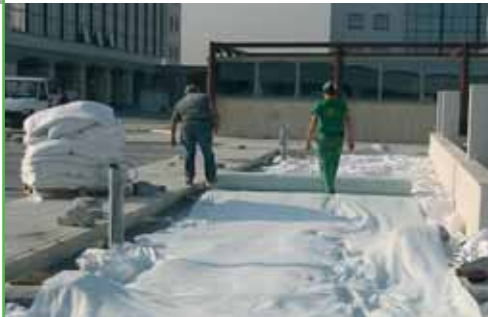
▼ Stesura dell'elemento filtrante DRENALIT® F
