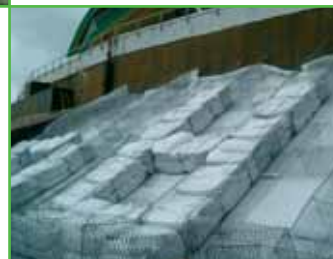
▼ Posa di sacconi di Igroperlite® su copertura inclinata
