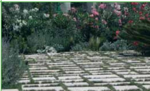
▼ Particolare di pavimentazione in pietra integrata con la vegetazione e appoggiata direttamente su sacchi di Igroperlite®
