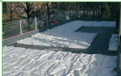
▼ Esempio di stratigrafia: membrana antiradice – lastre Supergarden – sacchetti Igroperlite®
