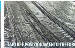
TAGLIO E POSIZIONAMENTO TREFORO
